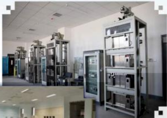
智能电梯安装调试 维护训练场所
